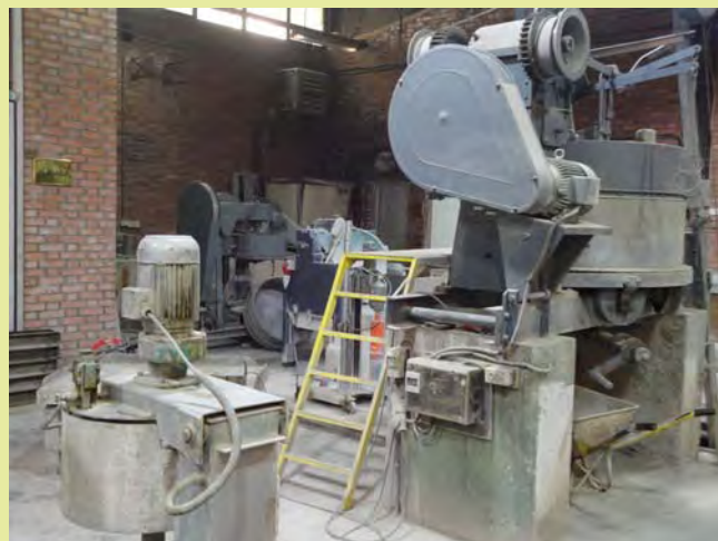
تجهیزات ساخت بتن
